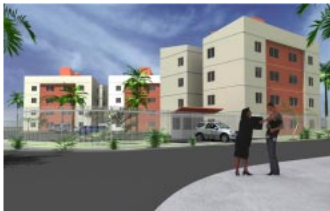
Fachada de uma das unidades do Residencial Umuarama que também é contemplado com a qualidade Elglobal
